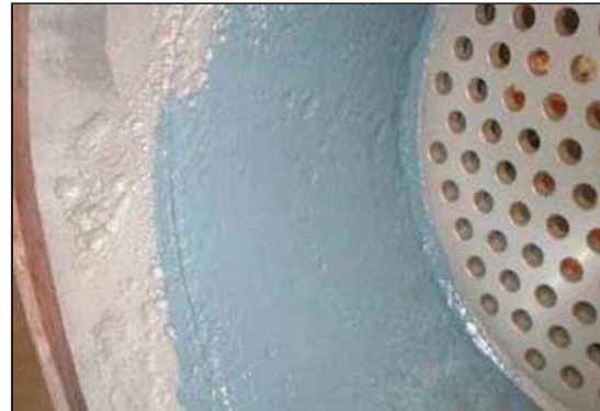
Después de la aplicación de ARC 858, ARC SD4i es aplicado para proteger y mejorar la eficiencia del flujo.
