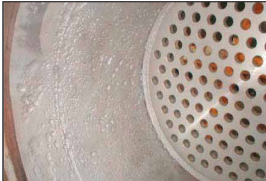
Después de la limpieza y descontaminación, ARC 858 es aplicado para rellenar y alisar la superficie.
