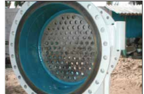
Vista del sistema terminado después de la aplicación de dos capas de ARC SD4i.
